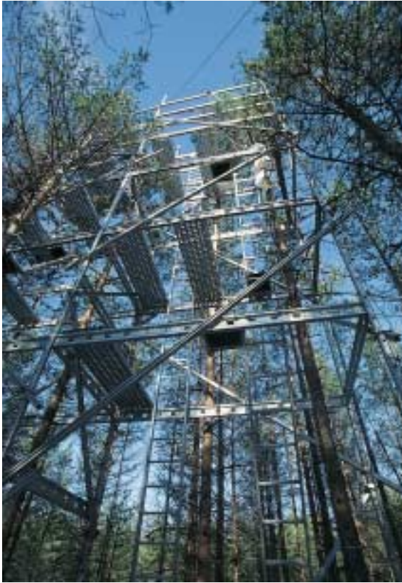
Kuva 8-1 SMEAR I -aseman mittaustorni Juupajoen Hyytiälässä. Mittausjärjestelmä antaa jatkuvaa tietoa puiden ja ilmakehän vuorovaikutuksesta, ilman laadusta ja aerosoleista. SMEAR II -asema sijaitsee Sallan Värriössä, SMEAR III on kaupunkiasema Helsingin Kumpulassa. (Kuva: Esko Kuusisto)
